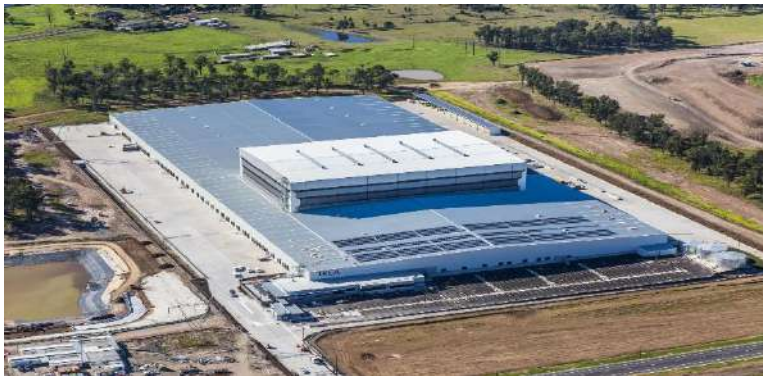
IKEA MLFU Rooftop PV Project
